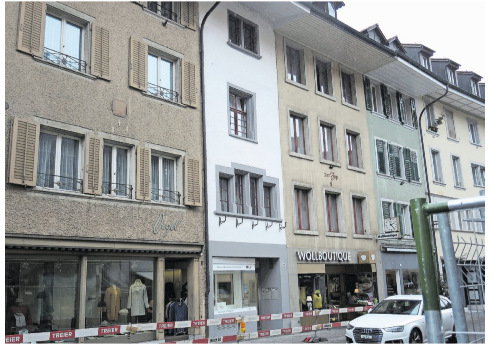
Das «schmalste Haus der Altstadt» (Mitte) wurde umfassend renoviert. Bild: pbr
